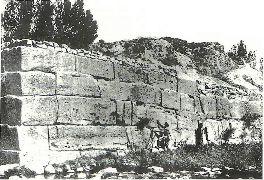
4 - Mur ouest de la Sardursburg où se trouvent trois des six duplicata de l'inscription de fondation de Sarduri I.
