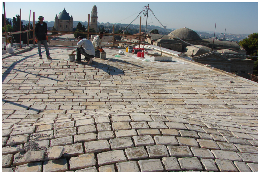
Նկ. 11. Ս. Յակոբեանց Մայր Տաճարի վերնատան տանիքի սալափառերու վերաշարում
