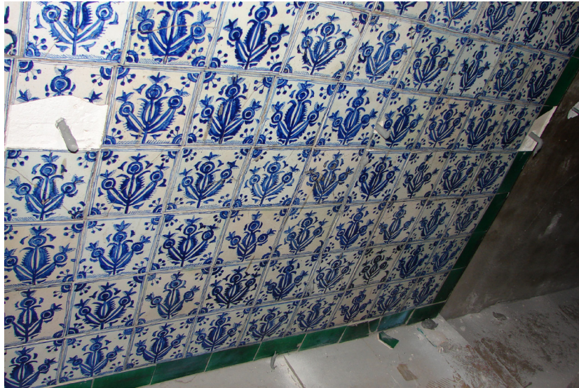
Նկ. 10. Մայր Տաճարի պատին մէջ անցքեր ընելու առէն վնասեցին Ս. Պօղոս մատրան փանի մը յախնապակիներ
