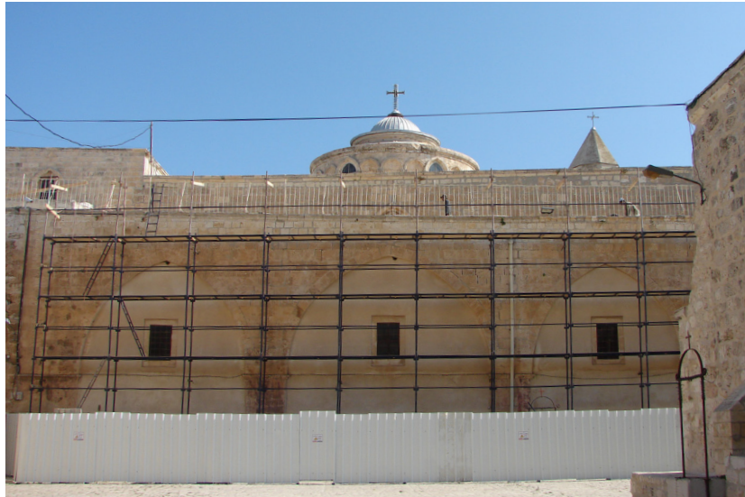
Նկ. 4. Նորոգությանց համար լարուած երկաթեայ յենակ-տախտակամած Ս. Էջմիածնի հարաւային պատին՝ Մեծ Բակին կողմէն
