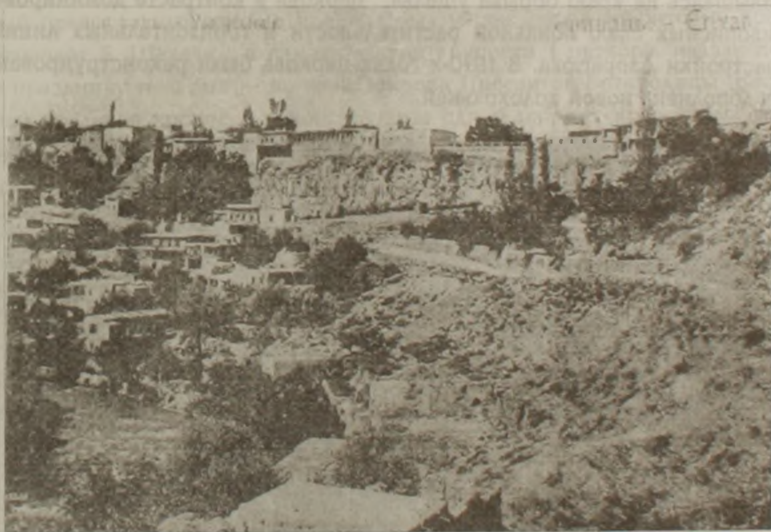
Рис. 1. Дзорагюх. Общий вид и церковь Сурб Саркис
