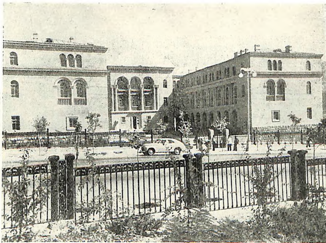
Ереван. Жилой дом „Каназа“ на ул. Баграмяна. Арх. З. Т. Бахшиян.
