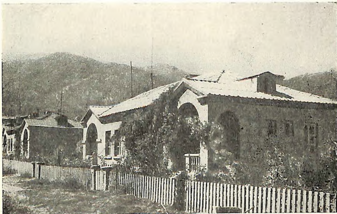
Кировакан. Двухквартирные жилые дома комбината им. А. Мясникяна. Арх. П. С. Манукян.
