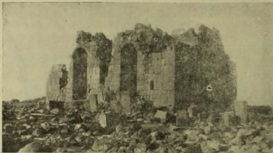
Рис. 11. Котаванк. Общий вид с северо-востока.
