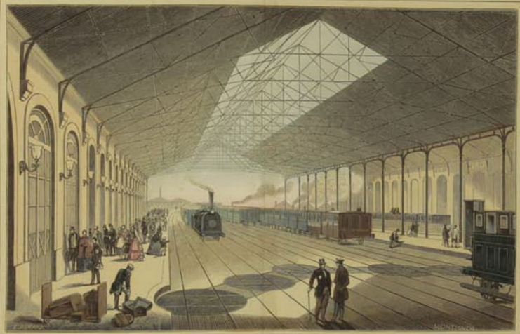
6. — INTÉRIEUR D'UNE GARE.
