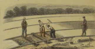
7. — Fosseur, chef d'équipe et hommes d'équipe, relevant les rails et remplissant les traverses pour les traverses injectées au collier de rails.
