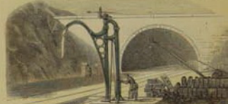
8. — Pompe d'élévation en grès hydraulique.
