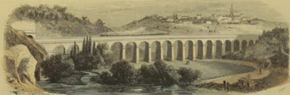
1. — Viaduc à dix-neuf arches avec parapet.
