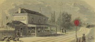
5. — Station. — Chef de station. — Surveillant. — Signal, face à la voie. Trompe, arrêt, arrêt, ralentissement, départ, la voie libre.
