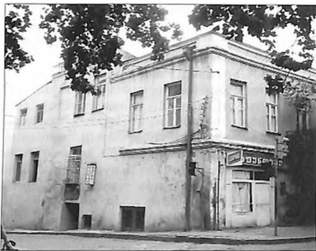
Дом Ханкаламянов, построенный на месте дома Г. Шермазянца, на углу Веляминовской (ныне-Дадияни, N 20) и Лермонтовской (до 1890-гг. называлась Большая Кривая) улиц (фото С. Дарчиняна).
