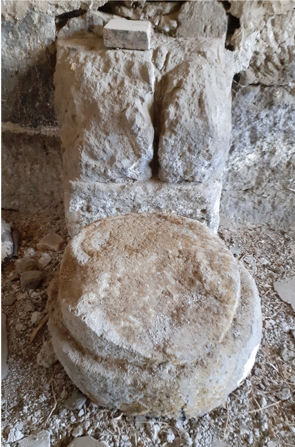
Նկ. 3 Հարավային պատի որմնամույթը սյան խարսխի հետ (լուսանկարը՝ Ռ. Գաբրիելյանի)
