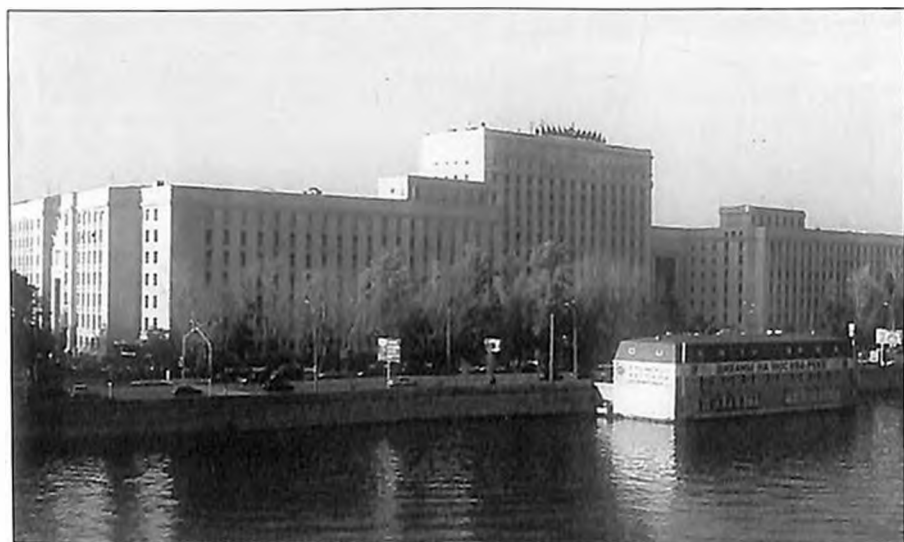
Здание Минобороны России, на котором установлена памятная доска маршалу.
