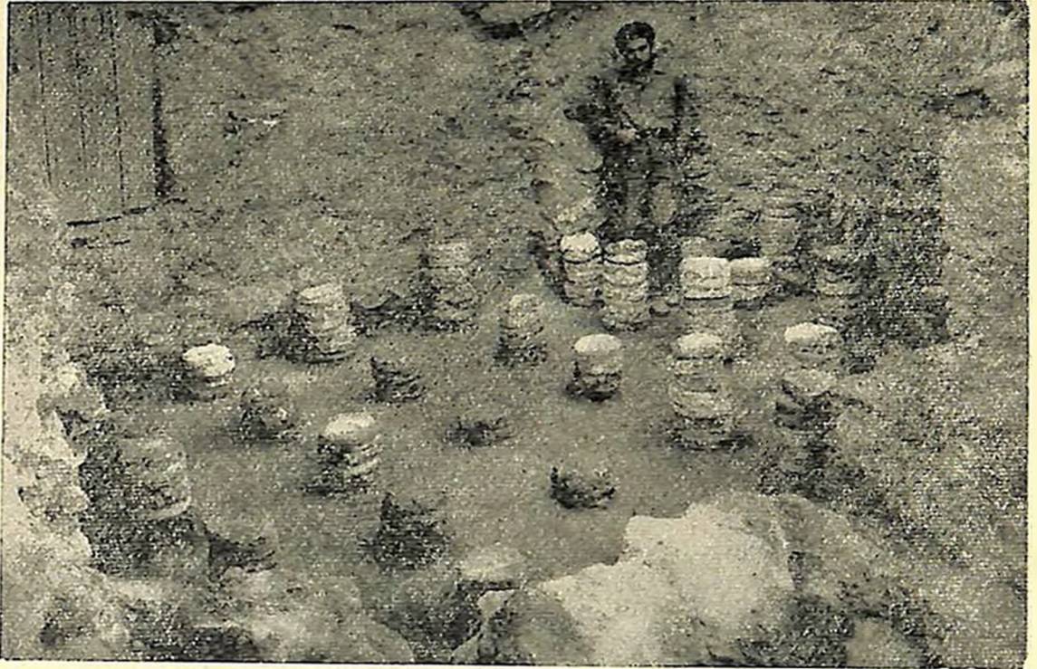
Գառնիի ամրոցի բաղնիքի ջեռուցման սիստեմը
