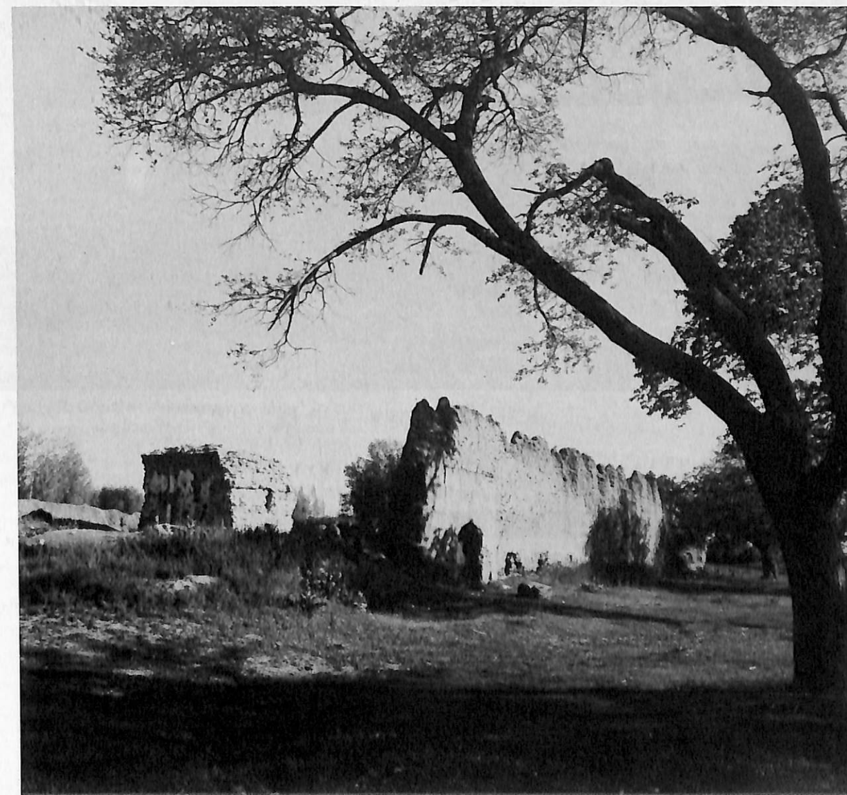
Figure 7: Couvent des Supplices de st Grégoire (Č'ari'aranic'vank'). Vue générale prise du sud-est.
