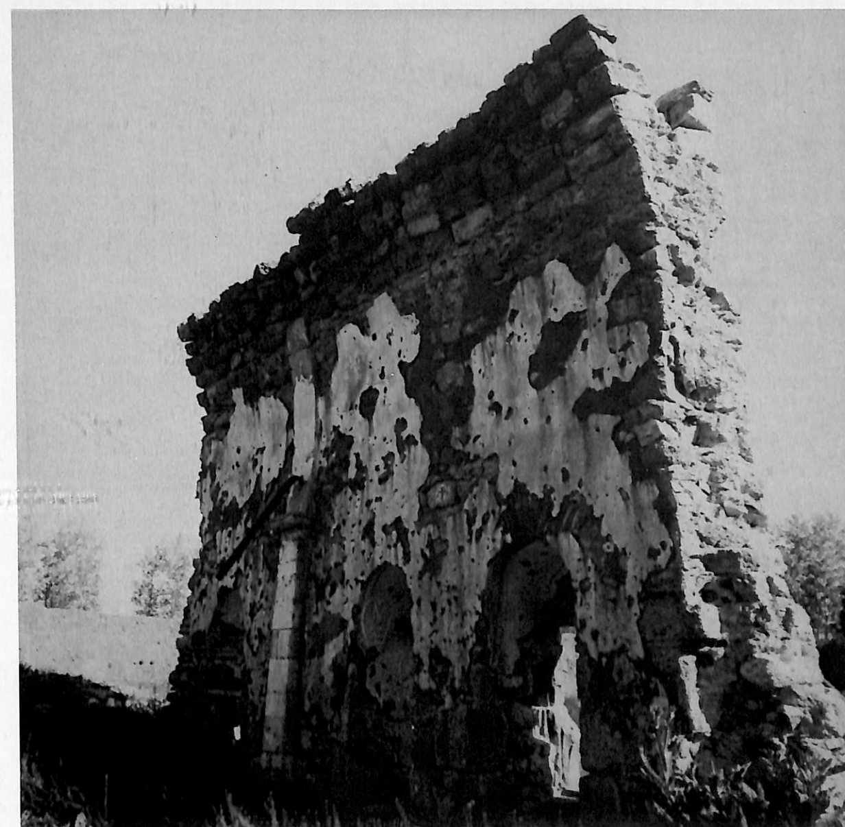
Figure 9: Couvent des Supplices de st Grégoire (Č'art'aranic'vank'). Eglise St-Grégoire. Paroi sud du mur nord.
