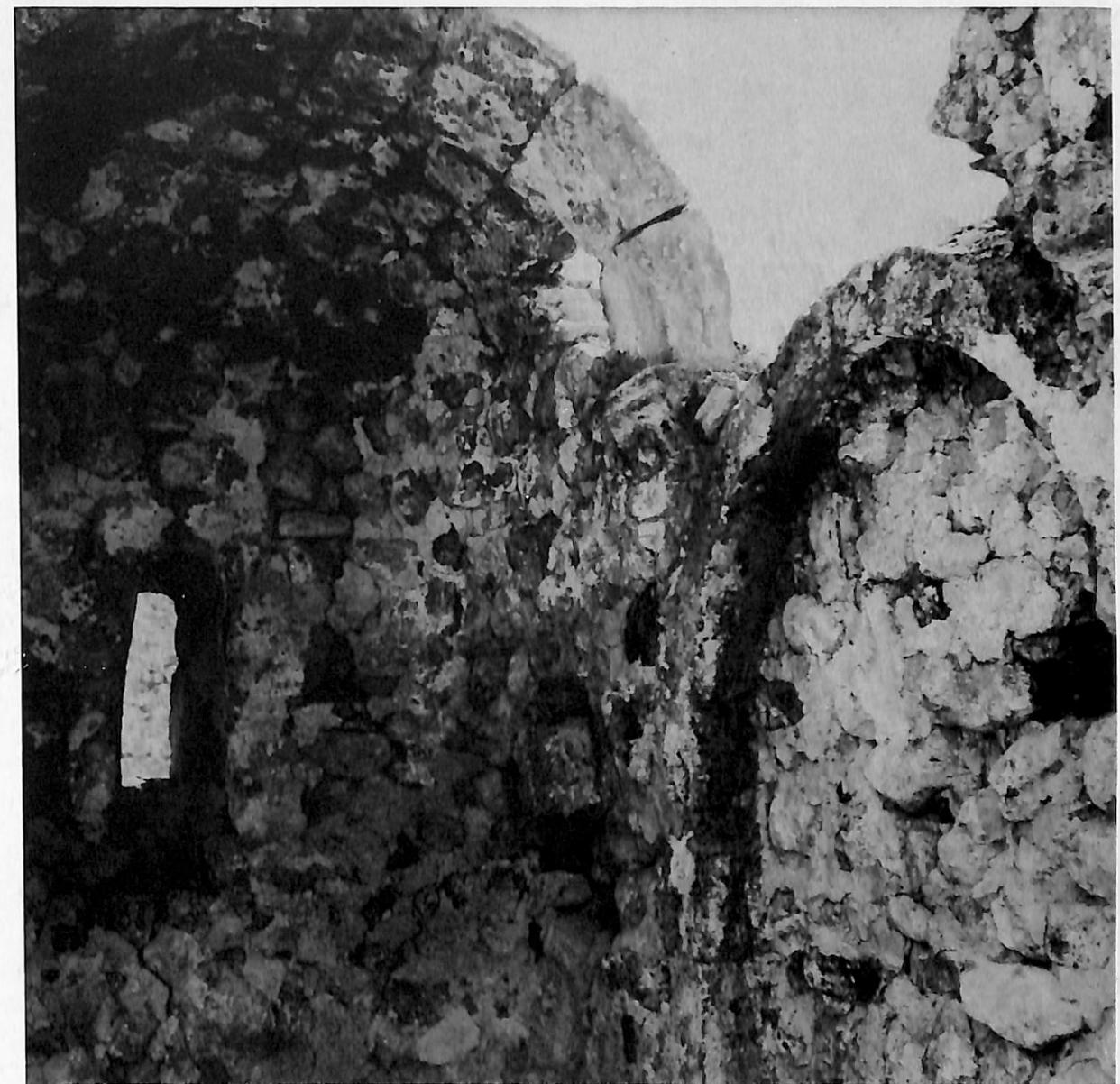
Figure 13: Couvent St-Georges d'Erkan. Eglise. Vue intérieure.
