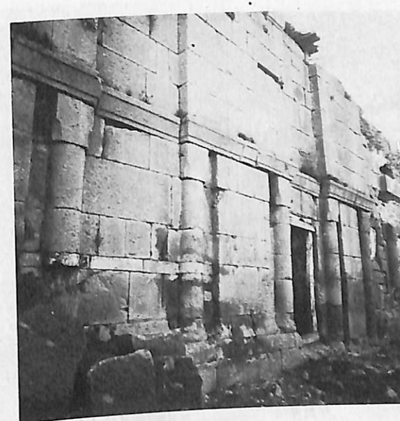
18. Bâtiments ouest. Façade.
