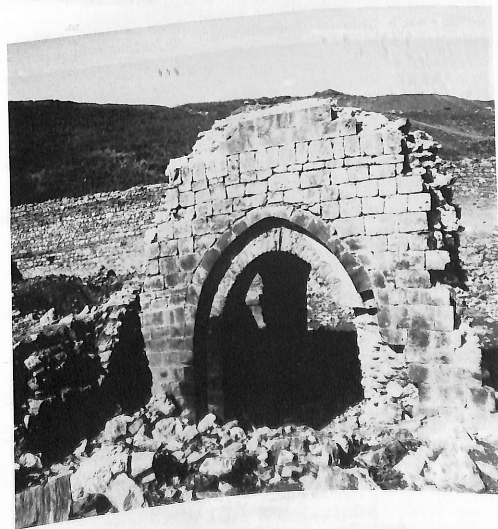
28. Clocher. Vue générale.
