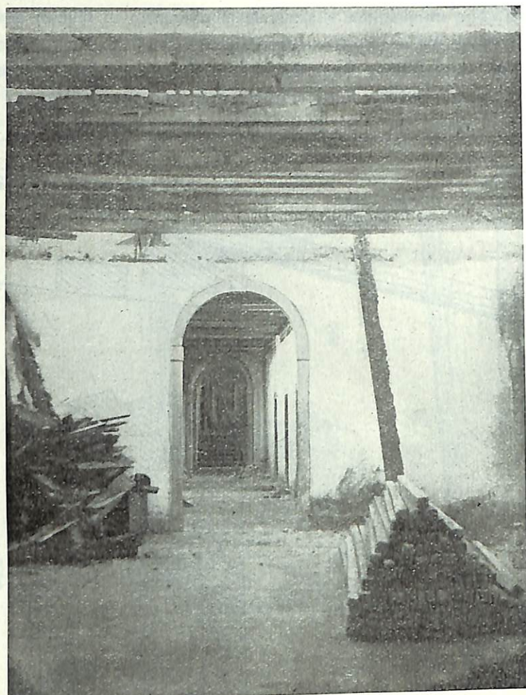
Fig. 12. — Stato dei fabbricati di S. Lazzaro dopo l'incendio del 1883 L'Interno del lato occidentale.
