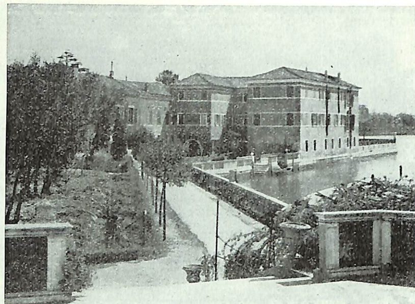
Fig. 14. — Stato attuale del lato occidentale — Ingresso e fabbricati del Noviziato.
