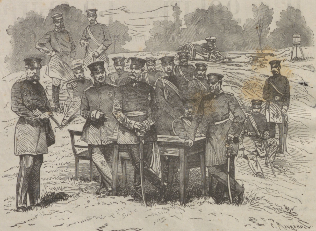
Le prince royal de Prusse et son état-major.
