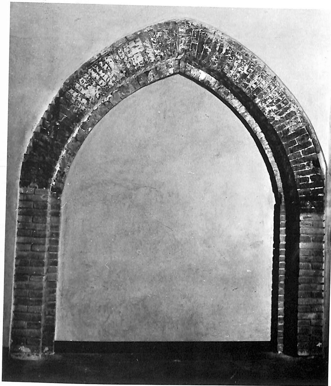
Գոթական կամար (աւանդատունէն տեսնուած), Ս. Ղազարի եկեղեցիին վերանորոգման փշխատանքներու ժամանակ յայտնաբերուած :
