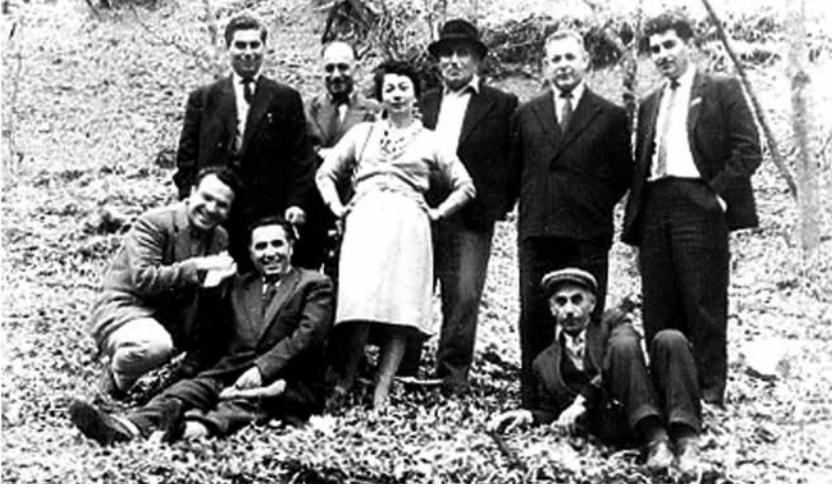
Архитектор Э. Алтунян, Б. Сосян (сидят слева), К. Кушнарева, гл. инженер «Армпроекта» М. Саакян, Э. Мирзоян со строителями. Начало строительства ДТК «Дилижан», 1961
