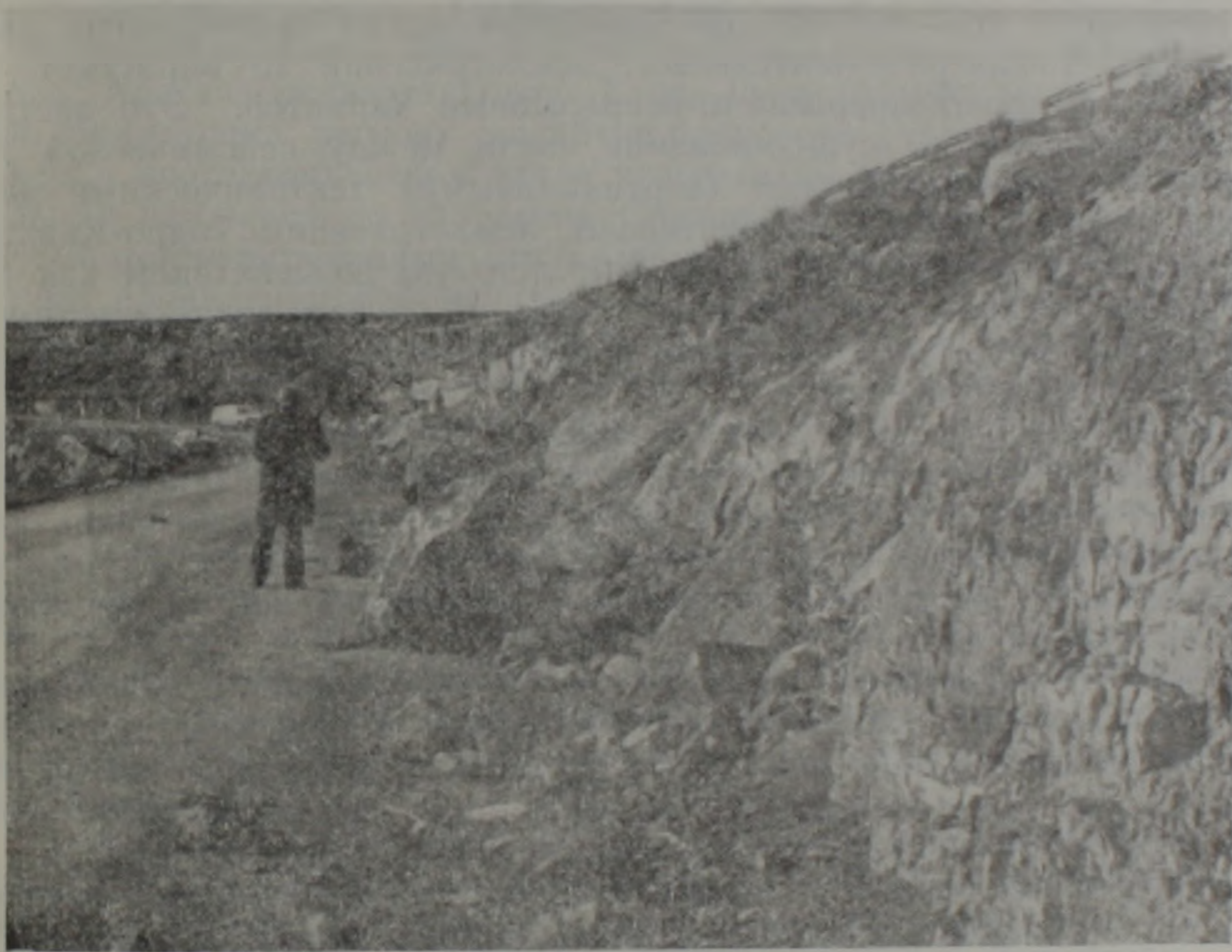
Рис. 3. Обвал крупных обломков туфов по дороге ж. д. ст. Налбанд—с. Сараарт.
