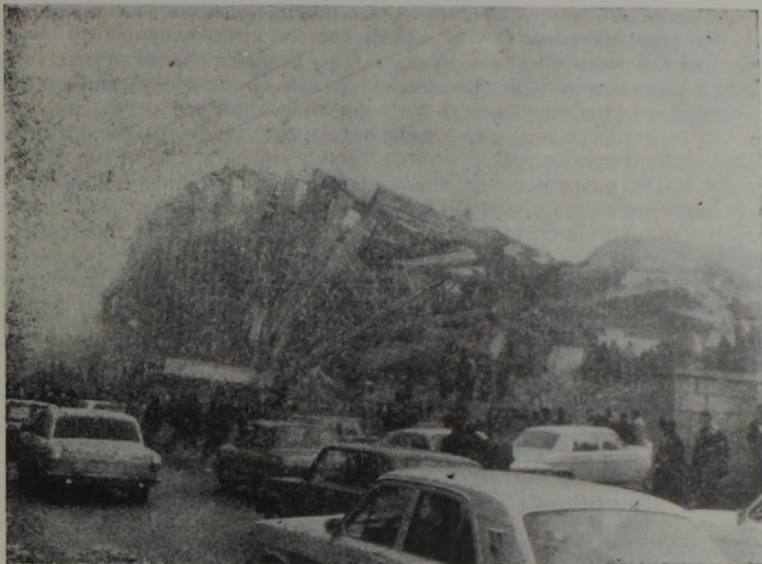
Рис. 3. Деформация здания центрального универсама, построенного в зоне исключаемой для строительства.
