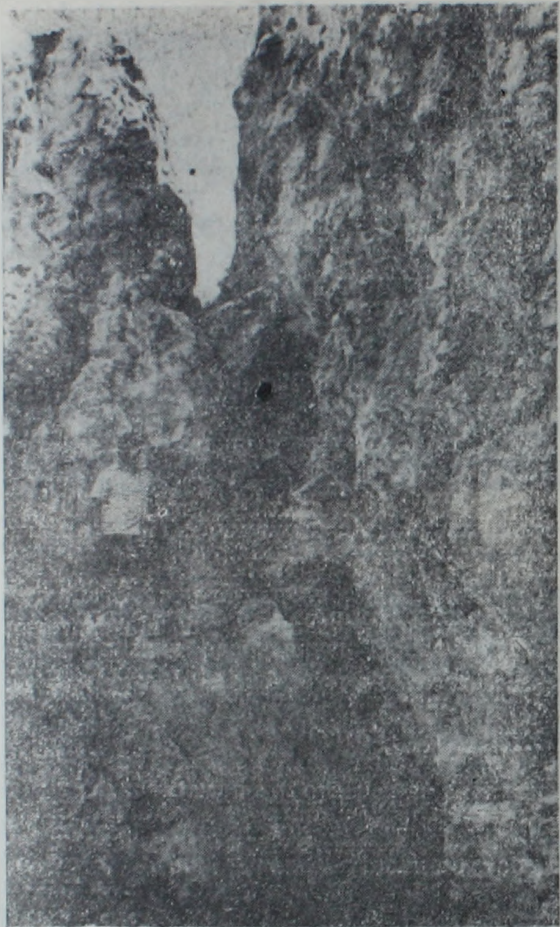
Рис. 6. Мыс Зюк. Трещина в скале.
