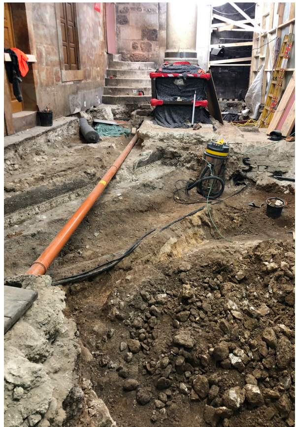
Յորդանանեան հին խողովակը փոխարինուած ժամանակաւոր ղողովակով
