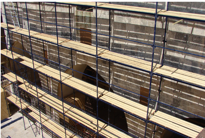
Նկ. 3. Նորոգութեանց համար լարուած երկաթեայ յենակ-տախտակամած Սրբոց Յակոբեանց Մայր Տանարի արտաքին գաւիթը
