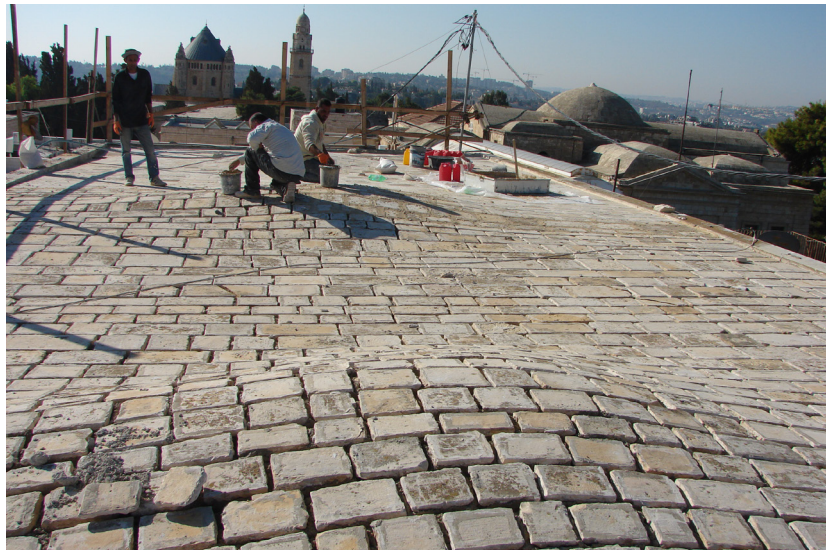
Նկ. 11. Ս. Յակոբեանց Մայր Տաճարի վերնատան տանիքի սալաքարերու վերաշարում
