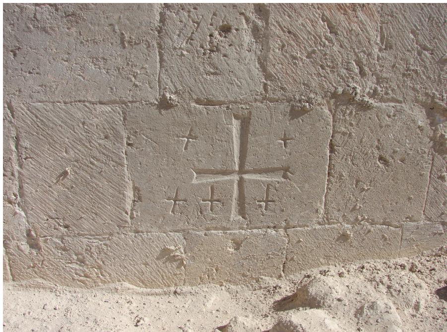
Նկ. 15. Սրբոց Յակոբեանց Մայր Տաճարի հարաւային արտաքին պատին, Ս. Էջմիածնի տանիքին, հիշդ պատումաններուն մօտ փորագրուած խոշոր խաչ մը՝ այլ փոքրիկ խաչերով, որ նախապէս ծածկուած էր հողով: Նորոգութենէն ետք դարձեալ ծածկուեցաւ հողով և ծեփով:
