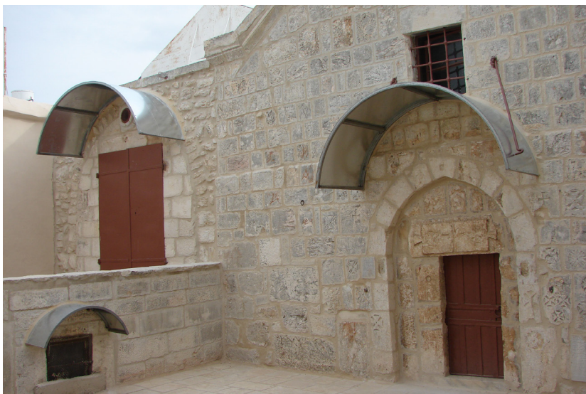
Նկ. 9. Ս. Առաքելոց եւ Ս. Համբարձման մատուռներու երկաթեայ դռները եւ անոնց վերի ծածկերը փոխուած
