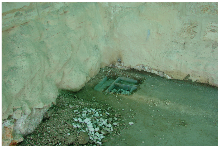
Նկ. 12. Փորձում Ս. Էջմիածնի տանիքին թափուած նոր պէթոնը՝ մոռցուած պողպատէ սալիկներն աւելցնելու նպատակով
