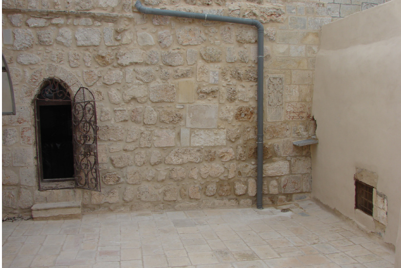
Նկ. 7. Ս. Առաքելոց մատրան բակի եւ յարակից պատերու նեղֆերու լիցք (ֆհօլէ)
