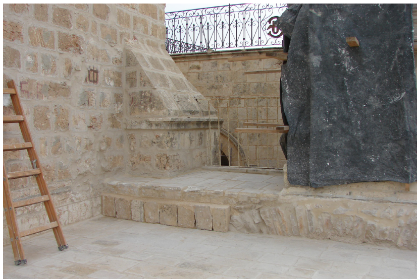
Նկ. 21. Ս. Էջմիածին եկեղեցոյ տանիքին արեւելեան կողմը նորոգութենէն վերջ: Ճիշդ Ս. Էջմիածնի Աւագ խորանին վրայ գտնուող ցցուն կամարը մասամբ սալափառուած
