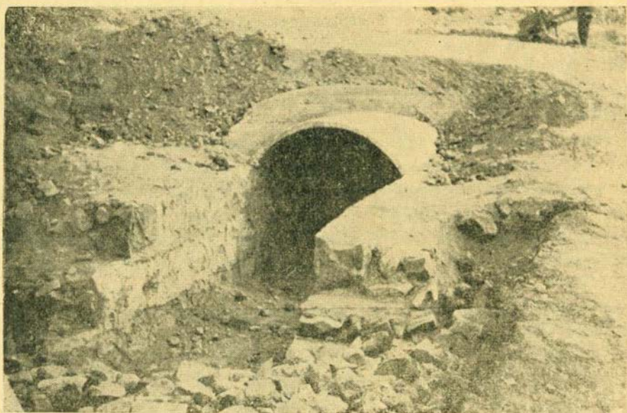
Рис. 3. Возведение безопалубочного свода над подземным каналом в окончательной стадии производства.
