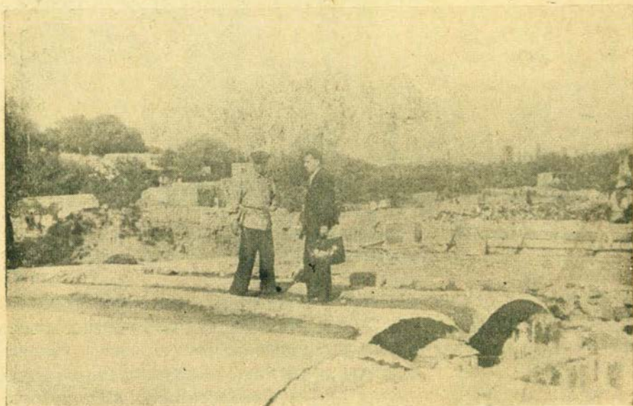
Рис. 4. Герекрытия пол подвальным этажем перед укладкой бетона на известково-пуццолановом вяжущем.
