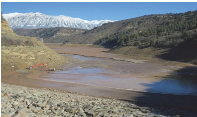
Рис. 1. Водохранилище Пония на р. Колорадо. За 50 лет эксплуатации 85% водовыпускной башни высотой 21 м было затоплено отложениями наносов
