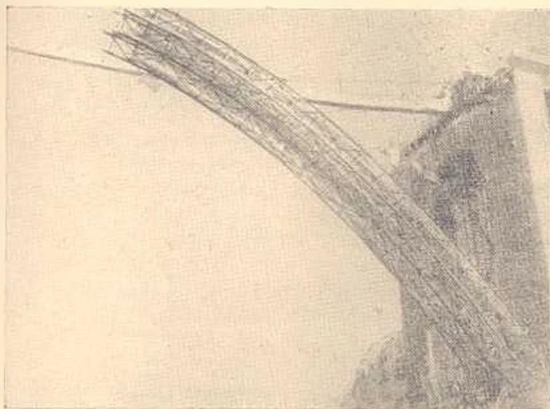
Рис. 6. Монтаж стального каркаса арки.
