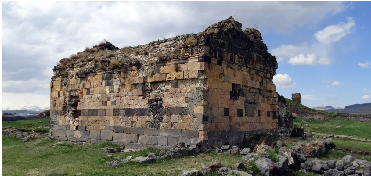
Le bâtiment civil du côté sud
