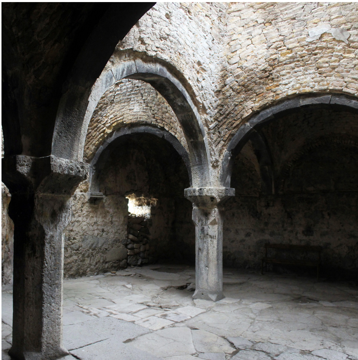
Les plafonds du bâtiment civil
