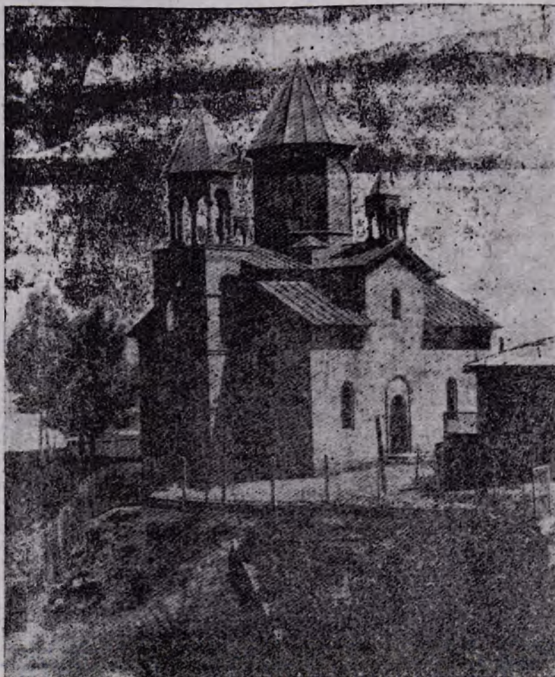
Рис. 1. Общий вид церкви Сурб Вардананц с юго-запада.
