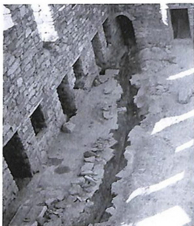
Водопроводная система выходящая из-под второй кельи
