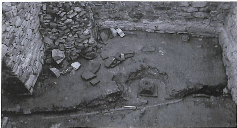
Открытая система водопроводных труб в «Хозяйственной комнате»
