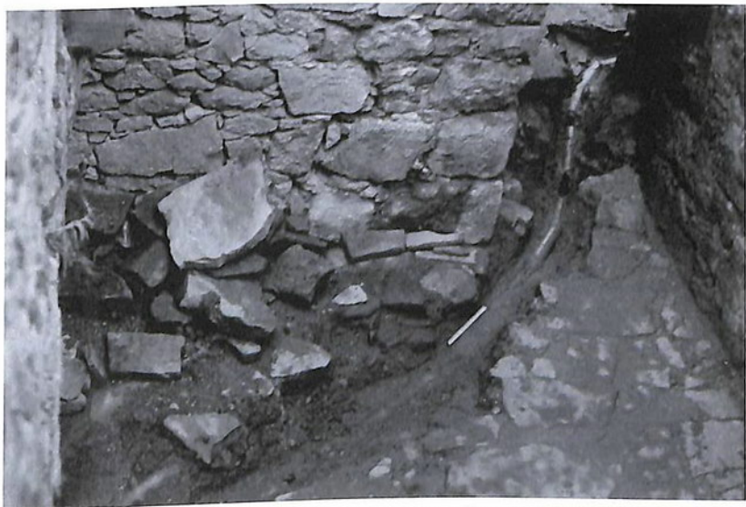
Водопроводная система, проходящая через крытый проход в «Хозяйственную комнату»
