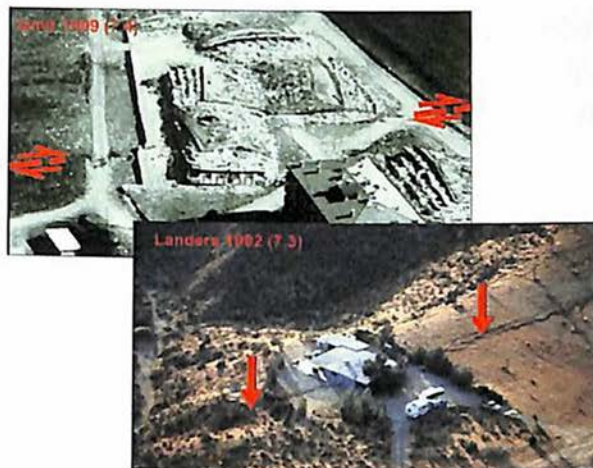
Նկար 3.33. Իզմիտի (Թուրքիա) 1999թ. և Լանդերի (ԱՄՆ) 1992թ. երկրաշարժերի ժամանակ մակերևութային խախտմամբ ավերված և վնասված կառույցներ (USGS տվյալներ):
