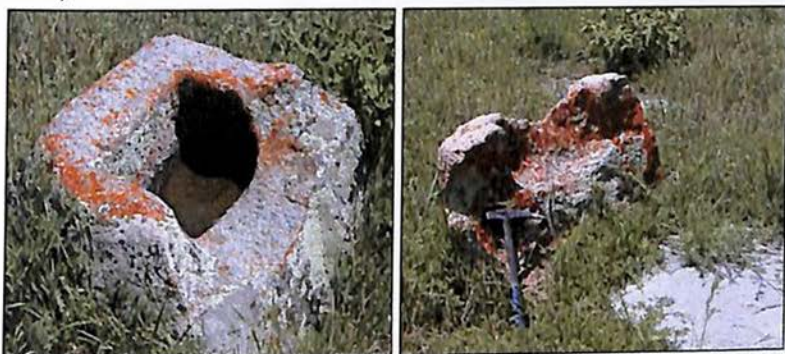
Նկար 4.10. Խաչքարերի հիմքերի սեյսմածին քանդվա-ծություններ:
