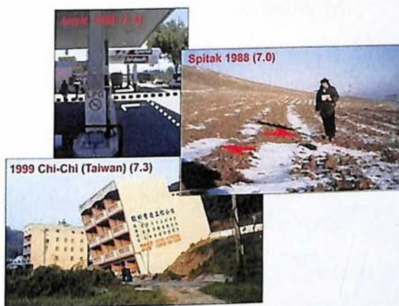
Նկար 3.34. Մակերեսային խախտմամբ տեղաշարժված կառույցներ (USGS տվյալներ) և ակոսներ (լուսանկարը Հ.Ֆիլիպի):
