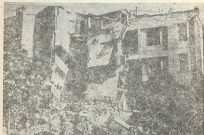
Նկ. 4. Քանզլան շենք Յկույն թաղարում՝ հույի երկրաշարժի հետևանքով
