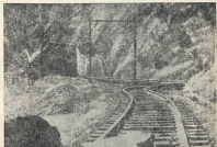
Նկ. 7. Երկրաշարժի շեղում Լաբադալին Կալիֆորնիայում՝ 1927 թ. Մայիսի 22-ի երկրաշարժի հետևանքով
