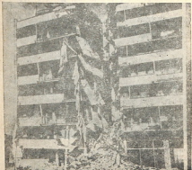
Նկ. 6. Քաղկեդ շենքի փլուզում Բուխարեսում՝ 1977 թ. ժառանգի երկրաշարժից
