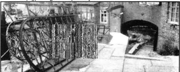
▼ Տեղահան արվեցին նաև լուսամուտների երկաթաձուլվանդակապատ ծաղերը (1995թ.), իսկ լուսամուտները ծածկեցին աղյուսապատով
