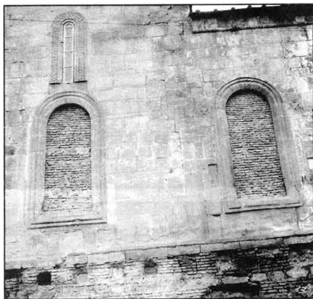
▼ Եկեղեցու ներքին ավերում-ձևափոխումները քողարկելու նպատակով աղյուսով պատված լուսամուտներ
