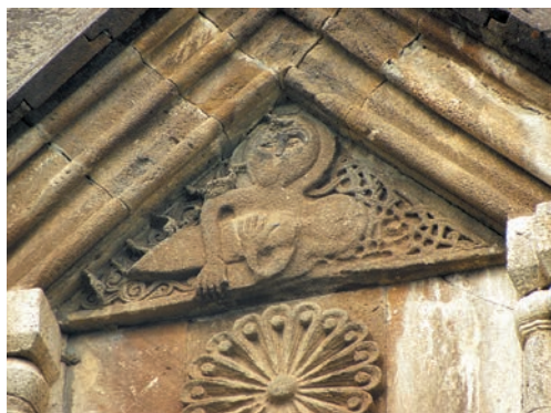
Рис. 9. Барабан церкви Ованнеса Мкртича. Гадзасар. Южная сторона. Рельеф фронтона. Фото Заруи Акопян
