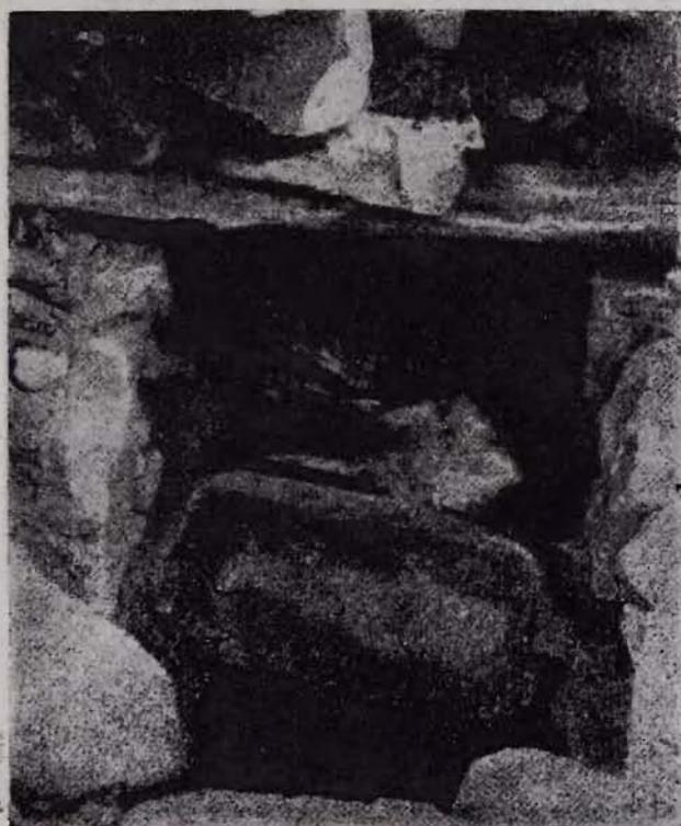
Рис. 61. Система перекрытия канала под стеной храма бога Халды
