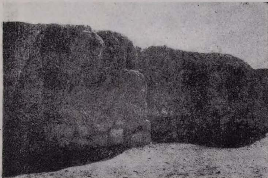
Рис. 49. Храм огня. Наружная стена двора с контрфорсами
