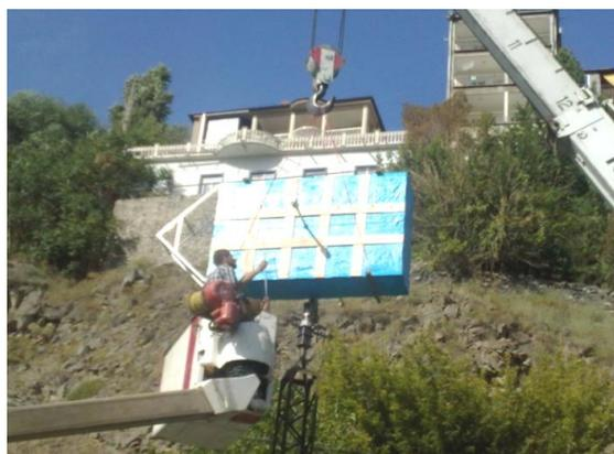
Рис. 9. Короб с полуволновым вибратором
