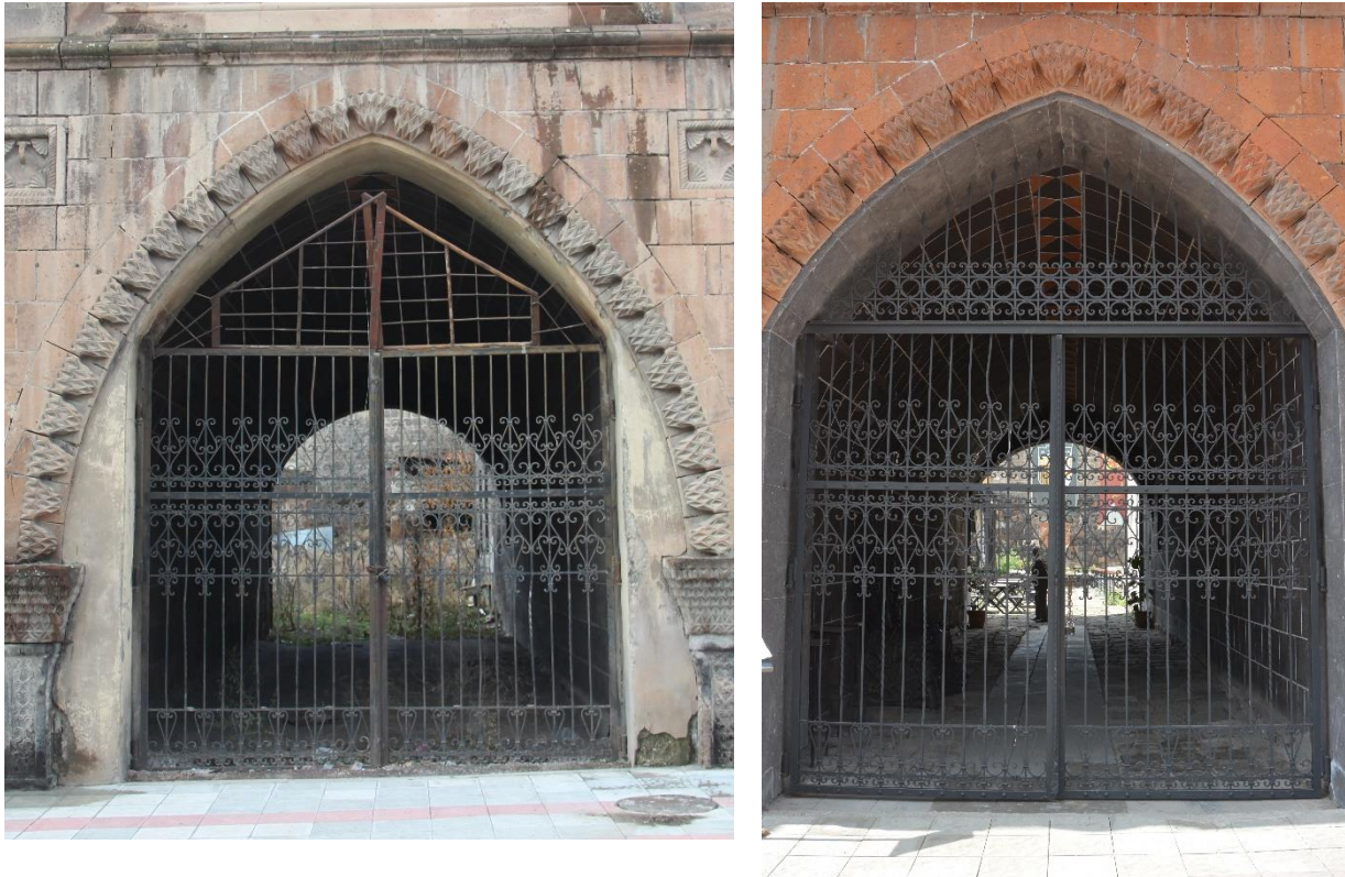
Նկար 2. Աբովյան 36 հասցեում գտնվող 1880-ականներին պատրաստված դարպասը վերանորոգումից առաջ և հետո
