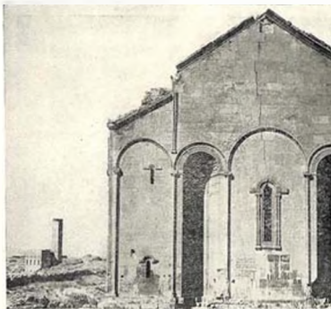
Собор. Восточный фасад
