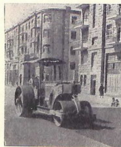
Փողոցի յարդարում Road construction
