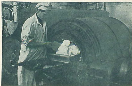
Մեքենական խնցիկէն կարագի գտումը Workman churning butter by mechanical process
