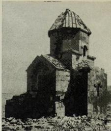
Лмбат. Общий вид церкви с юго-запада.
