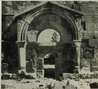
Авен. Портик западного входа храма
