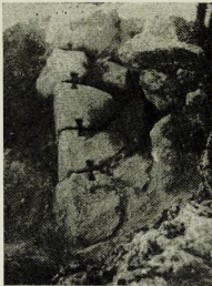
Арманир. Скрепление камней железными скобами.
