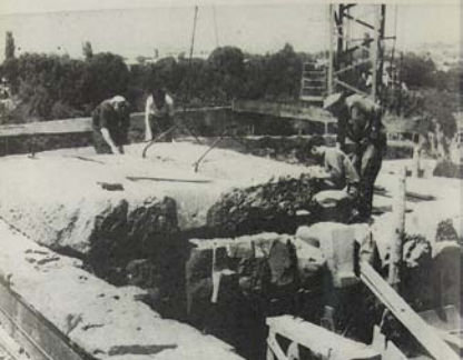
99. Гарюк. Устанавливается плет потолка прованского цеха.
