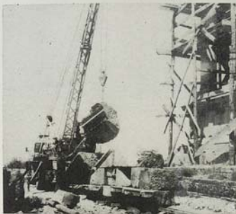
87. Горен — а) установка каменной нижней фронтальной арки,
