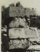
б) последовательное соединение каменных пиластров южной стены храма;
