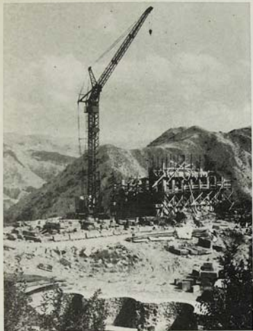
10. Гурян. Процесс восстановительных работ храма, вид с северо-запада.
