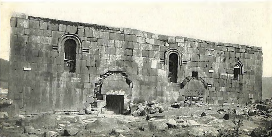
9. Касахская базилика. Вид с юга. III—V вв.
