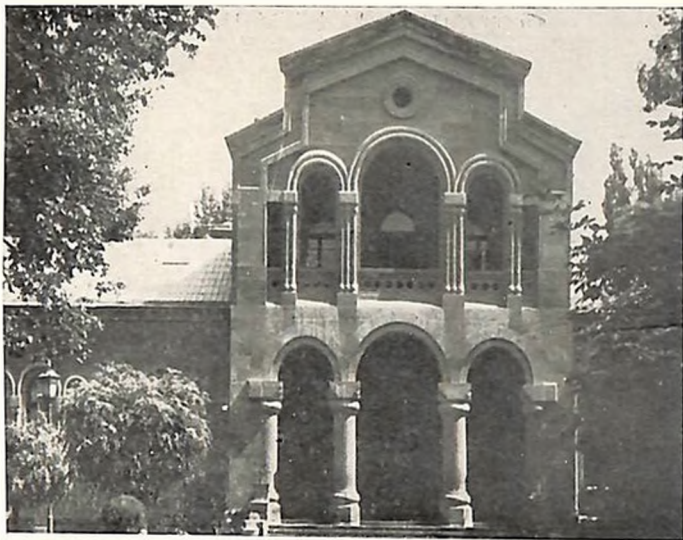
Здание Матенадарана в Эчмнадзине
