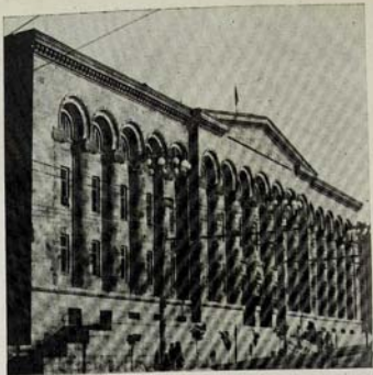
24. З. Бахшимян. Здание Ленинаканского горкома КП Армении. 1953 г. Использование на фасадах административных зданий парафраз правительственного дома А. Таманяна нередко канонизировалось.
