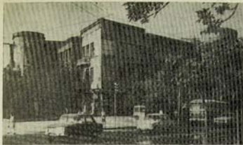
12. Г. Кочар. Административное здание на ул. Налбандяна 1 в Ереване. 1936 г.
