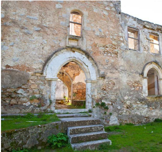
Նկ.4. Սուրբ Մակարավանքի պատուհանների շրջանակների ու հիմնապատերի վիճակը
