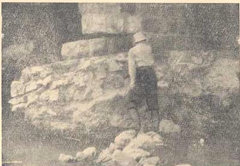
Рис. 5. р. Дзкнагел. Обнаженная и разрушенная опора моста на шоссеиной дороге.
