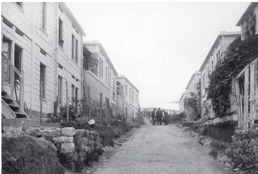
Construction des premiers quartiers résidentiels pour les réfugiés arméniens à Beyrouth à partir de la fin des années 1920. Ici, on voit les Pavillons Blancs, sur la colline d' Achrafiyeh (coll. Archives Bibl. Nubar/Paris)
