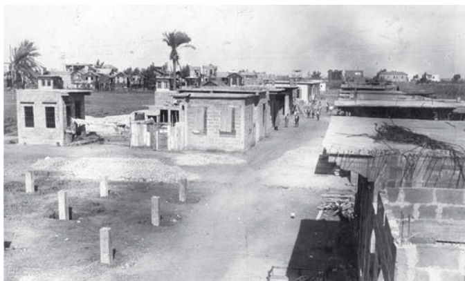
Construction du quartier Paréchèn , à Bourj Hammoud , au début des années 1930 (coll. Archives Bibl. Nubar/Paris)
