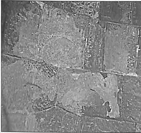
Նկար 3. Սուադի հեռացումը մաքրման նպատակով:
