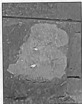
Նկար 18. Պատմական սուադի քանդման հետեւանմով առաջացած պատի սպիտակ հատուածները:
