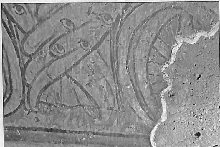
Նկար 30. Նախֆինում միայն կրով՝ առանց կապակցող նւթի, արուած վերանորոգումները:
