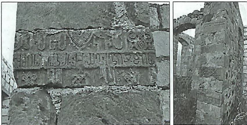
Նկար 2. Ծար. Խորհրդային շրջանում կառուցուած դպրոցի պատերի մէջ որպէս շինաքար օգտագործուած ջարդոտուած խաչքարերի եւ արձանագրակիր քարերի բեկորներ:
