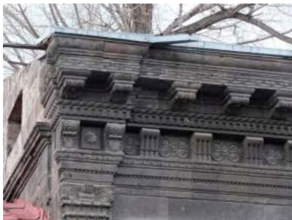
Илл. 14. Перебивка осей кронштейнов в боковых частях фасада «Дома с двумя карнизами». Фото автора, 2018
