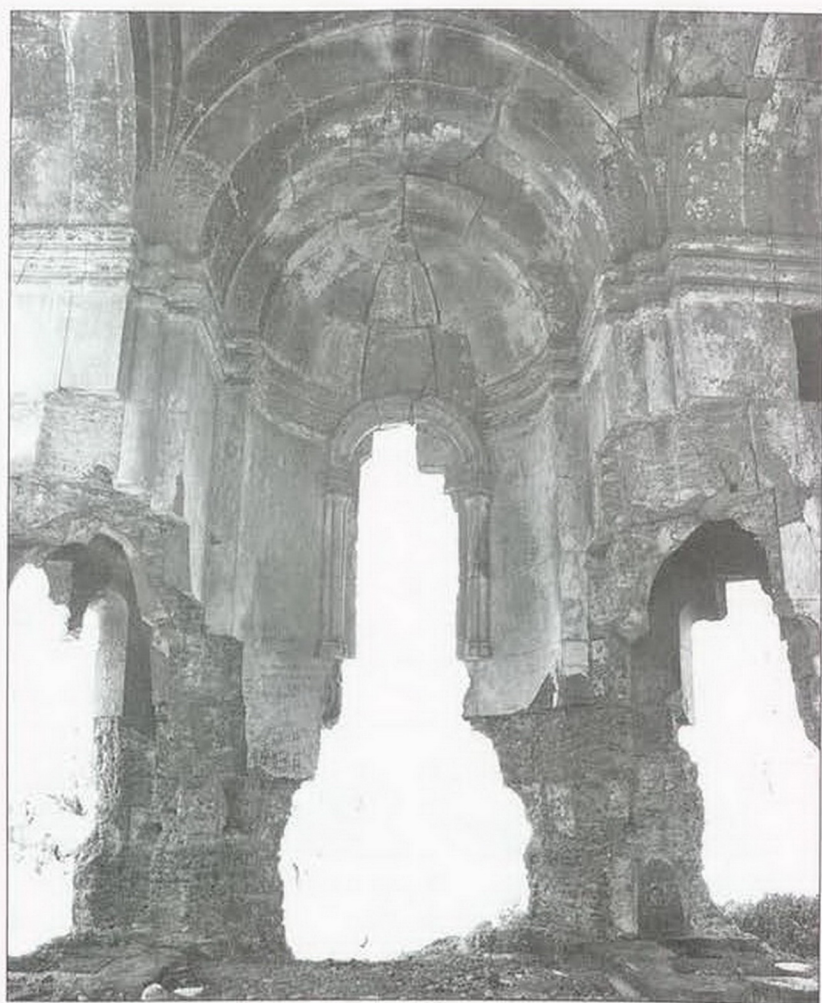
Fig. 5. Saint-Serge. Vue intérieure avec bande moulurée au bas des culs-de-four. Conque ouest (2013).
