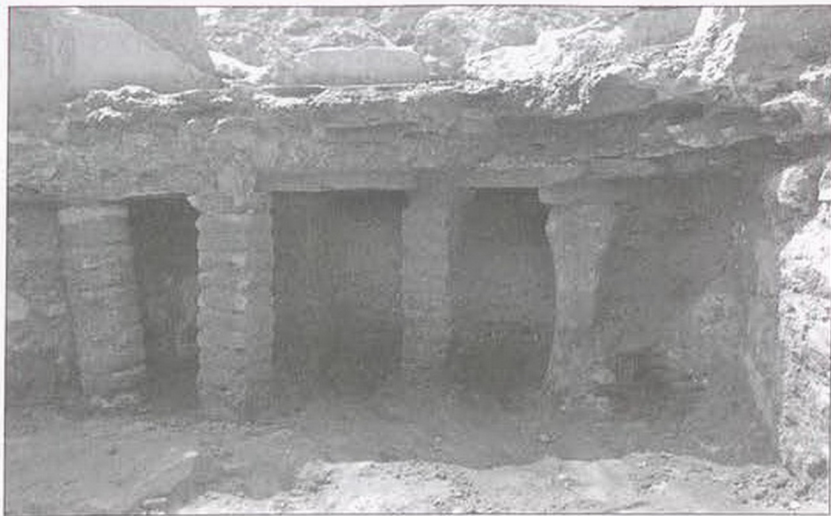
Նկար 11. Բաղնիքի նկուղային հիպոկաուսային համակարգը
